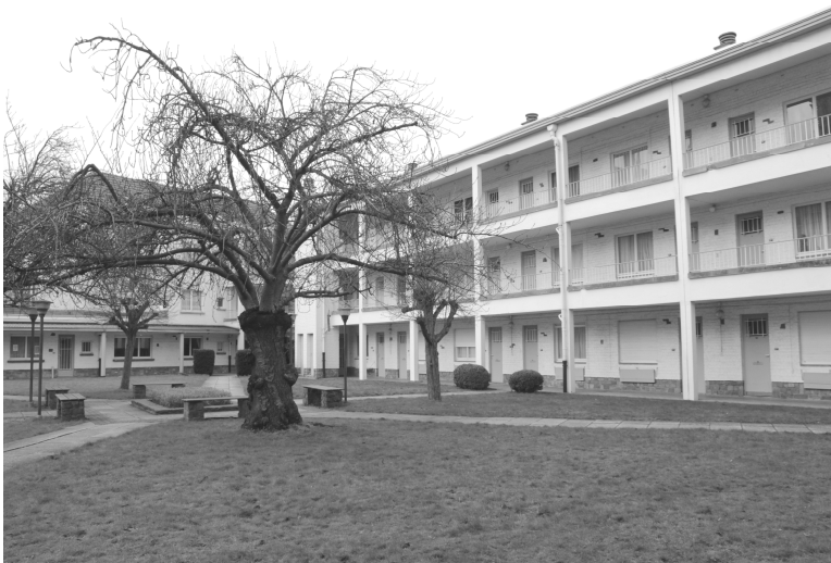
Binnenzicht van het Mellery Complex
